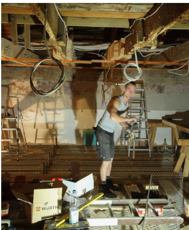
Sägewerk Bohm bei der Dachreparatur, Foto: MKC
